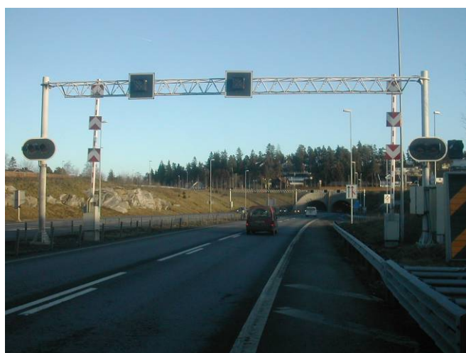
Over er eksempel på bommer i tilknytning til tunneler. Disse kodes som bilsperre.
