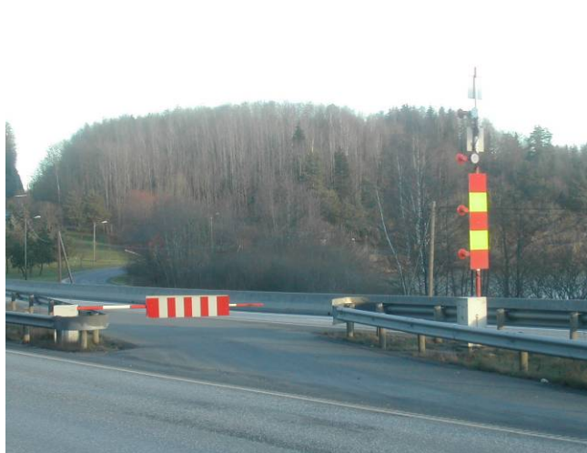
Over er eksempel på bommer i tilknytning til tunneler. Disse kodes som bilsperre.
