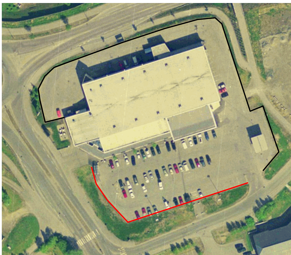
Figur 29: Det kan være vanskelig å skille mellom parkeringsplass og annet vegareal. Dersom man ønsker å registrere parkeringsplass fotogrammetrisk, anbefales det derfor at det utarbeides manuskart. Dersom manuskart ikke er utarbeidet, vil det ikke være krav om at det skal være mulig å danne flate av parkeringsplassene. Over er et eksempel på en mulig registrering av et parkeringsområde ved et kjøpesenter. Rød strek er ParkeringsområdeAvgrensning og svart strek er AnnetVegarealAvgrensning.
