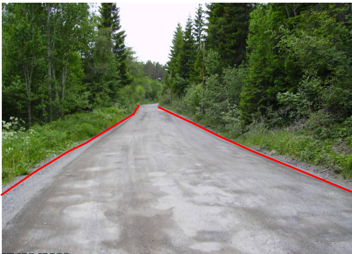
Figur 8: Eksempel på registrering av Vegdekkekant for grusveg.
