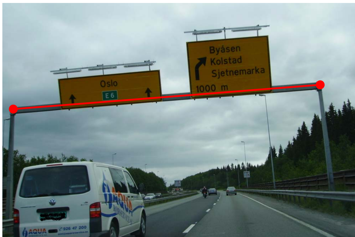
Figur 32: Eksempel på registrering av Skiltportal (rød strek). Det er ikke nødvendig å registrere stolpene som skiltportalen er festet i.
